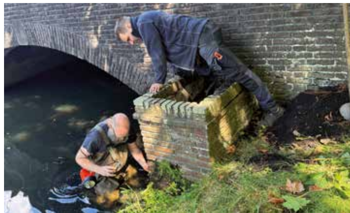
Inspectie van de situatie onder de Parkenbruggen
