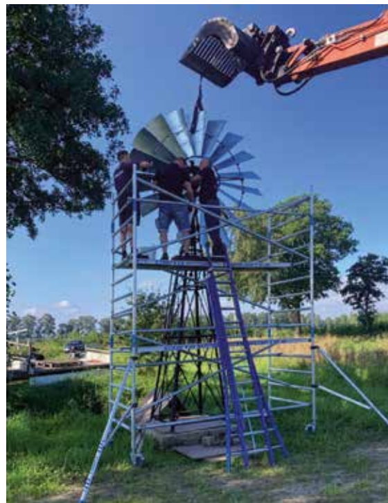
Restauratie en opbouw van de Piepmolen
